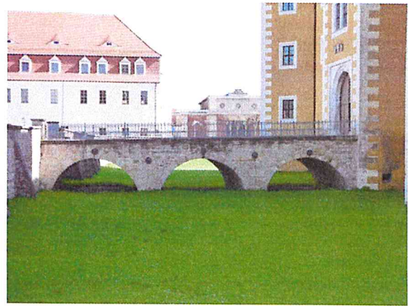
Abbildung 17: Schlossgrabenbrücke zum Hinterschloss
