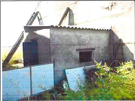
Foto 13: Hallenanbau zu Anbringung von Rauchschwalbennisthilfen (K1) – Ansicht Nordseite (Foto: Wiesner, 13.8.21)
