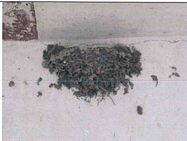
Foto 9: Rauchschwalbennest an der Innenwand des Schuppens (Foto: Wiesner, 13.8.21)
