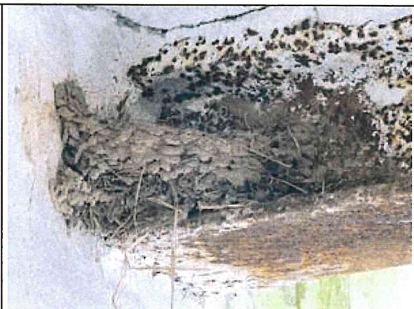
Foto 8: Rauchschwalbennest auf einem Stahlträger (Foto: Wiesner, 13.8.21)
