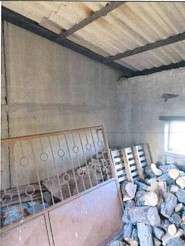
Foto 15: Innenansicht des Anbaus (Foto: Wiesner, 13.8.21)
